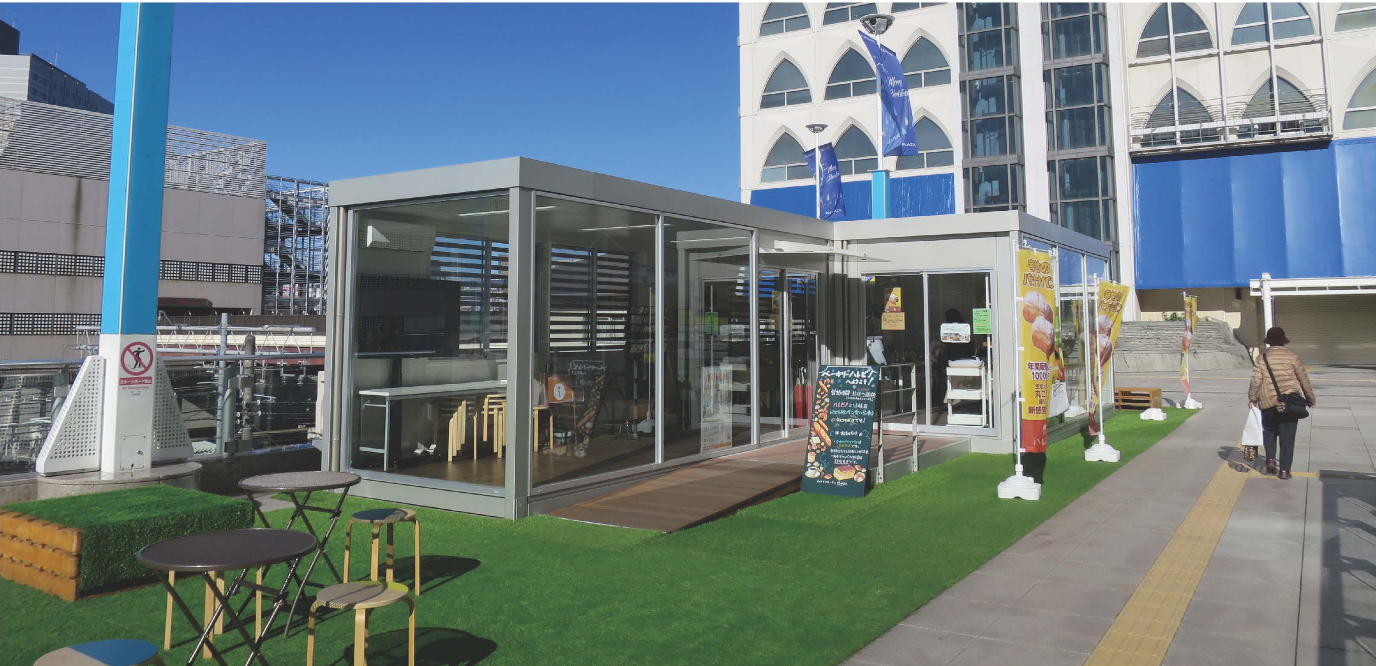
写真 6 仮設運用中のカシワテラス 手前インフォハウス、奥にぎわいハウス
