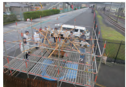
竹製街具の組立作業
