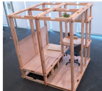
【木製内装システムの開発】 建設業界では将来、熟練技能者が不足するため、居住者がセルフビルドで組み立て可能な内装システムを開発
