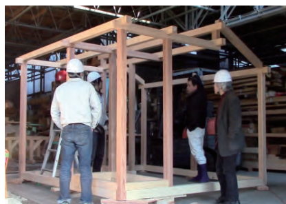
木造インフィルユニットの試作
